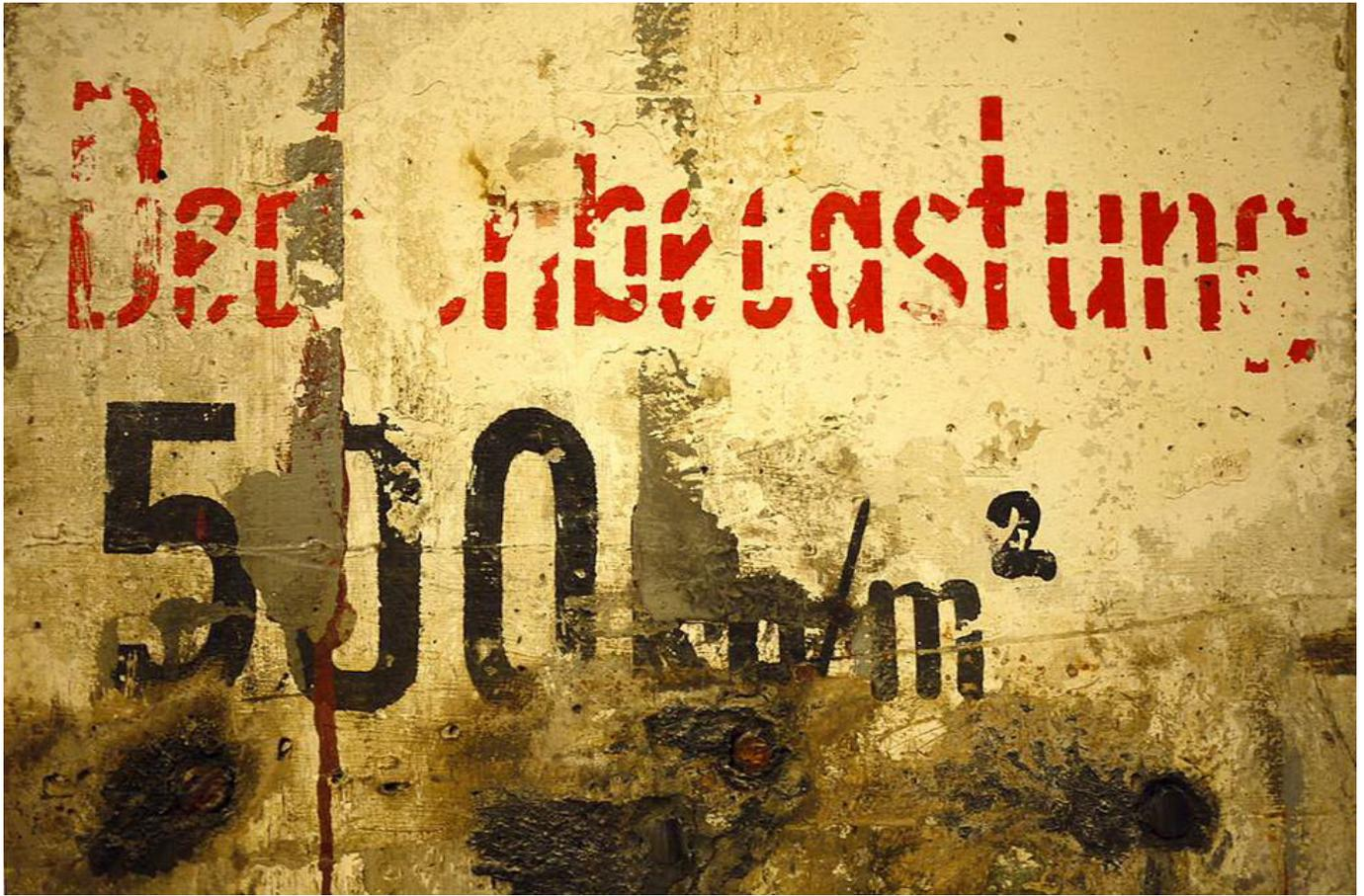
*Foto: Deckenbelastung 500 kp/m<sup>2</sup> - (c)2010*
