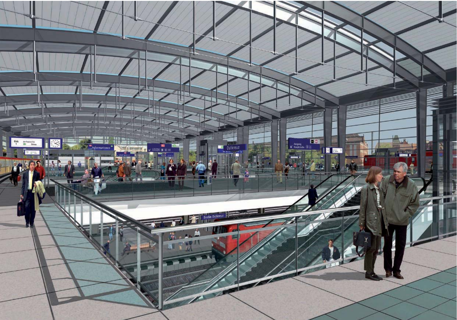
Die neue Halle für die S-Bahn, Gleis 11 und 12 (Ringbahn)
